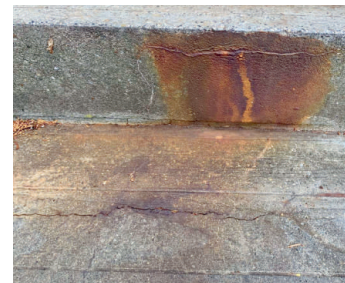
Stahlbeton mit Rissen und Abplatzungen.
