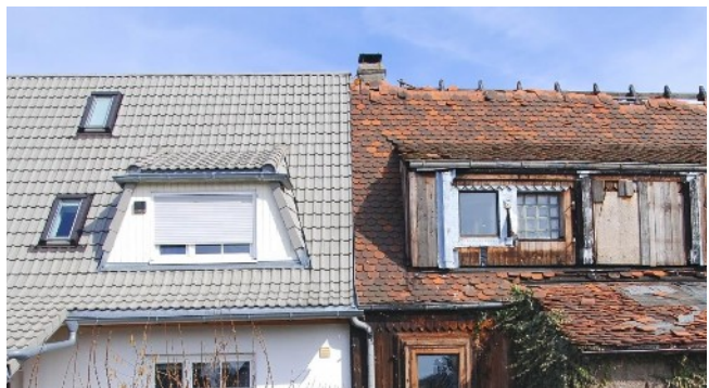
Sanieren statt Neubauen
